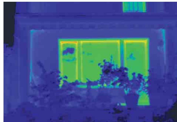
Nach dem sorgfältigen Einbau neuer Schüco Thermo 6 Classic-Energiesparfenster beweist die Thermografie den hohen energetischen Nutzen der Investition. Der ursprüngliche Energieverlust wird nahezu vollständig vermieden.
